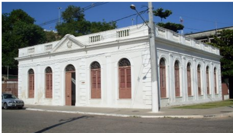
Fig. 01 – Antiga Casa da Alfândega/ Atuais Escritórios: Técnico II do IPHAN/MS e Local do SPU, 2010. Fonte: Restaurador Marcelo Mariz
